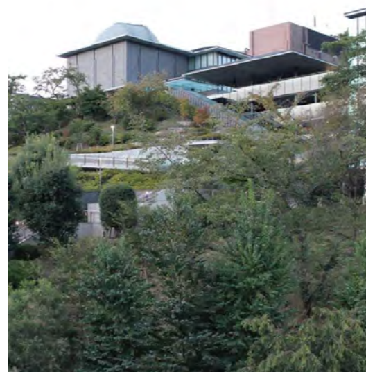
外装仕上げの様子 寄棟屋根：金属板葺き 外壁：レンガ(既存天文台)
