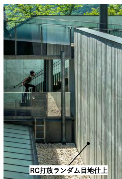
外壁：RC打放ランダム目地仕上 (サギタリウス館)
