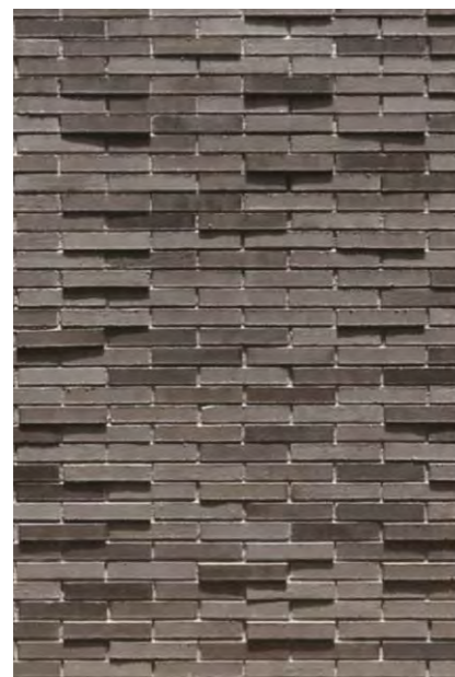
外壁：レンガ(既存15号棟)
