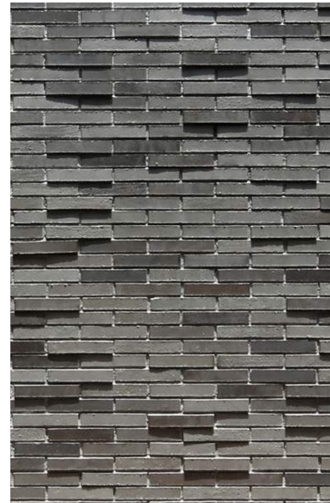
外壁：レンガ（既存15号館）
