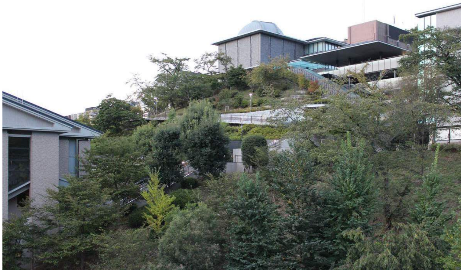
外装仕上げの様子 寄棟屋根：金属板段葺き 外壁：レンガ（既存天文台）
