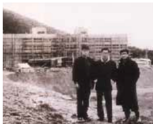
わが子とともに建築の現場を見回った先生(右端)
